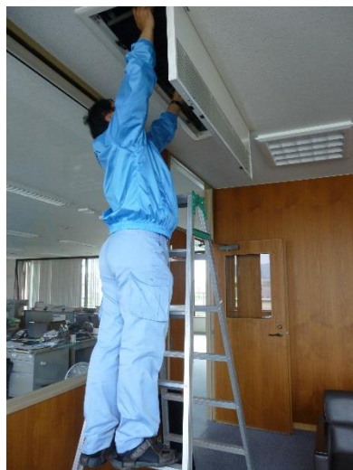
【エアコンフィルターの清掃】
