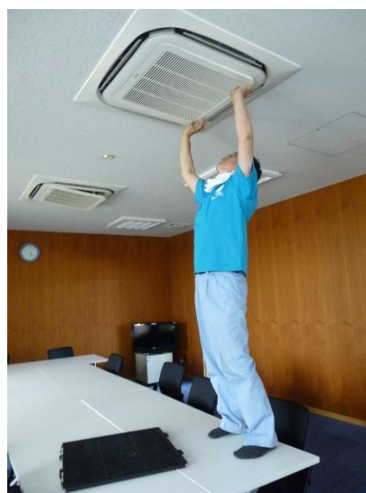
【エアコンフィルターの清掃】
