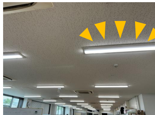
照明（214基）LED化完了！
