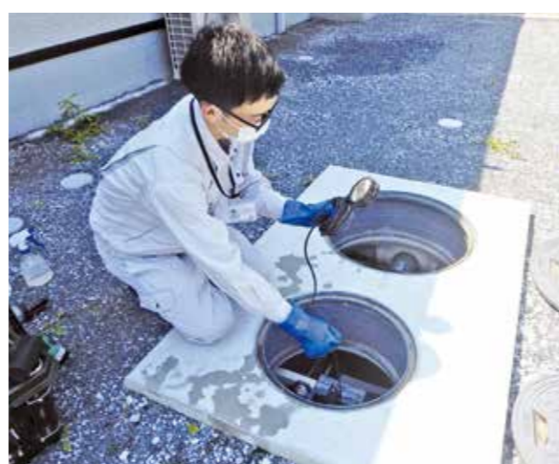
浄化槽の設置場所での検査
