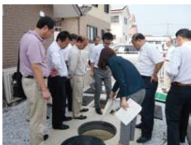
住宅の浄化槽
