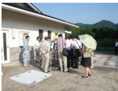
農業集落排水施設
