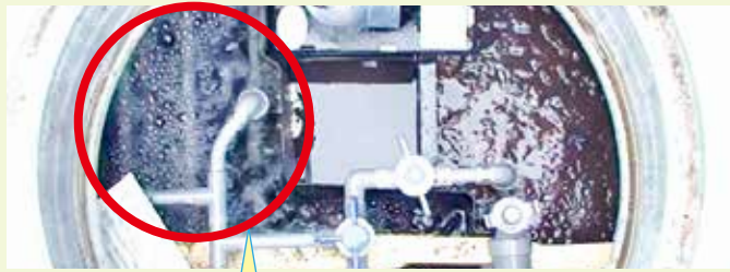
接触ばっ気槽の下部にはろ材受け面がありませんので、塩ビパイプでろ材を押すことができます。挿入箇所を変えて、全面をほぐすようにろ材を動かしてください。
