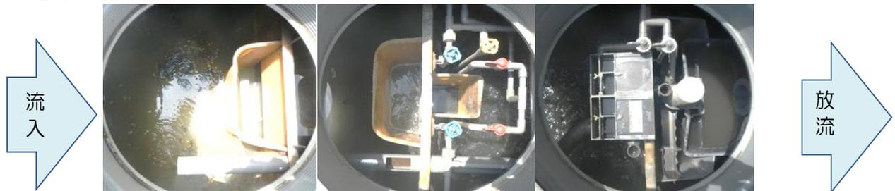
①嫌気ろ床槽第1室 ②嫌気ろ床槽第2室 ③接触ばっ気槽 ④沈殿槽及び消毒槽
