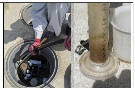
エアブローによる担体流動槽の生物膜剥離作業と、剥離した生物膜のようす。
