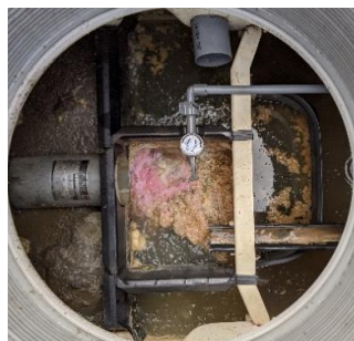
①沈殿分離槽 ②嫌気ろ床槽 ③担体流動槽 ④処理水槽及び消毒槽
