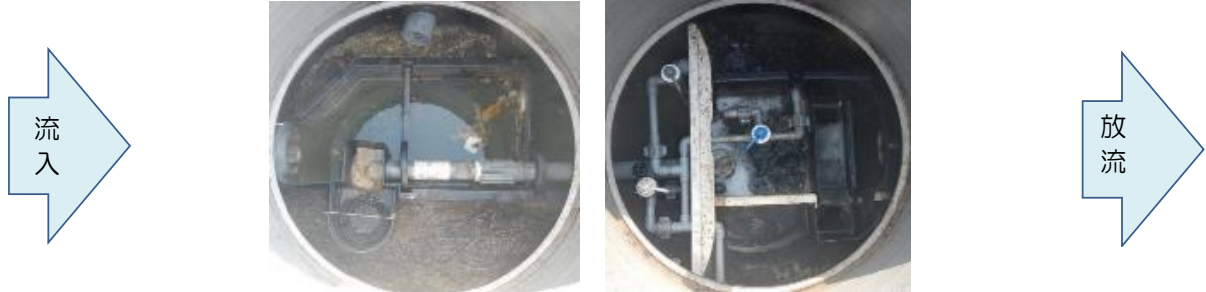
①汚泥貯留槽 ②担体流動槽 ③沈殿槽及び消毒槽 ※担体流出防止ネットと消毒薬筒は外しています。
