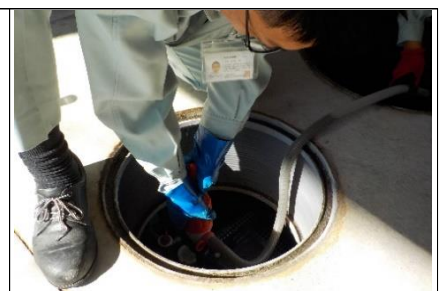
手動汚泥移送ポンプによる汚泥移送の様子
