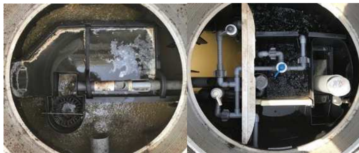
①汚泥貯留槽 ②担体流動槽 ③沈殿槽及び消毒槽 ※担体流出防止ネットは外して撮影しています。
