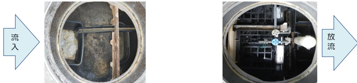
①夾雑物除去槽 ②嫌気ろ床槽
