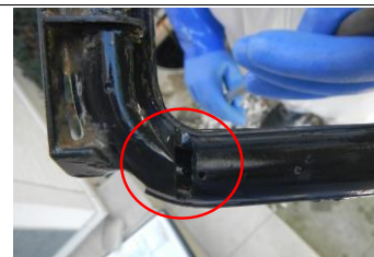
散気管(散気部)の破損箇所
