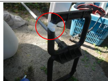
補修後の散気管
