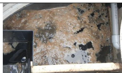
沈殿槽の様子
